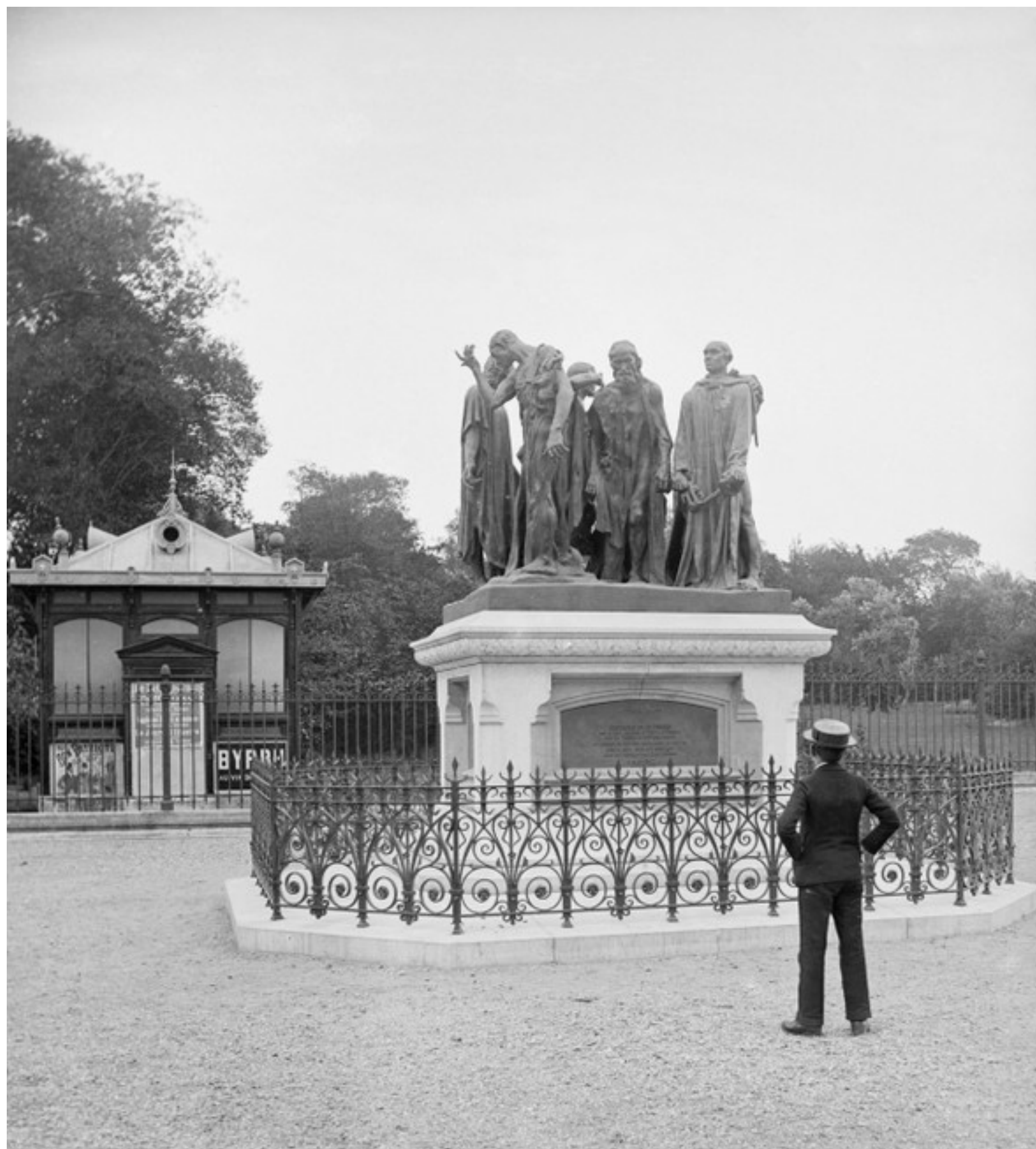
RODIN, Les Bourgeois de Calais , 1889, œuvre installée en mai 1895, Calais, socle conçu par l'architecte Ernest Decroix. Installation sur le terre-plein situé entre l'hôtel des Postes et le jardin Richelieu.
